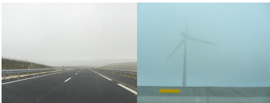
Ilustración 53.- Infraestruturas viarias. Autovía do cantábrico no seu paso polo territorio e os seus problemas de visibilidade.
